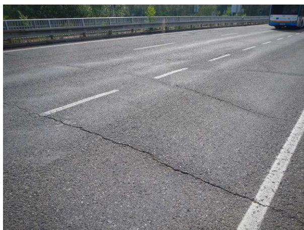
Hlubková koroze, příčné trhliny
