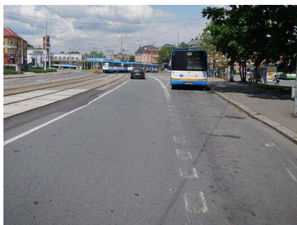
PJP – ztráta makrotextury, olejové úkapy od autobusů
