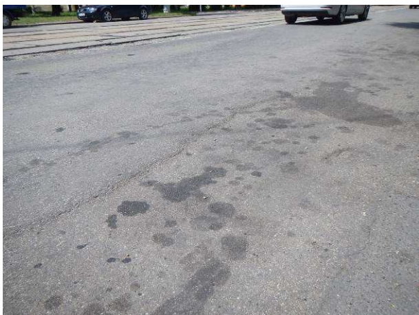
PJP – úkapy, nerovnosti povrchu, trhliny
