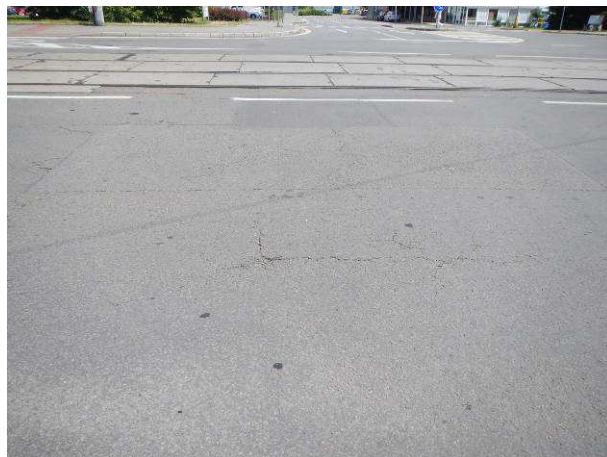
LJP – začínající mozaikové trhliny, hloubková koroze
