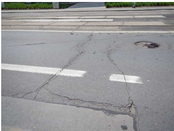
PJP – Rozvětvené příčné trhliny, hloubková koroze
