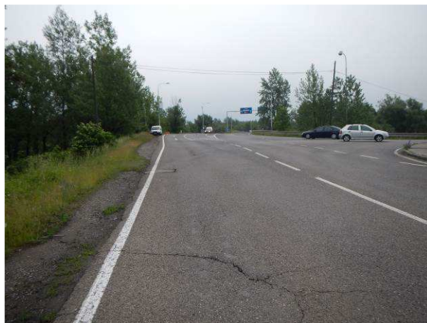
Hlubková koroze, mozaikové trhliny
