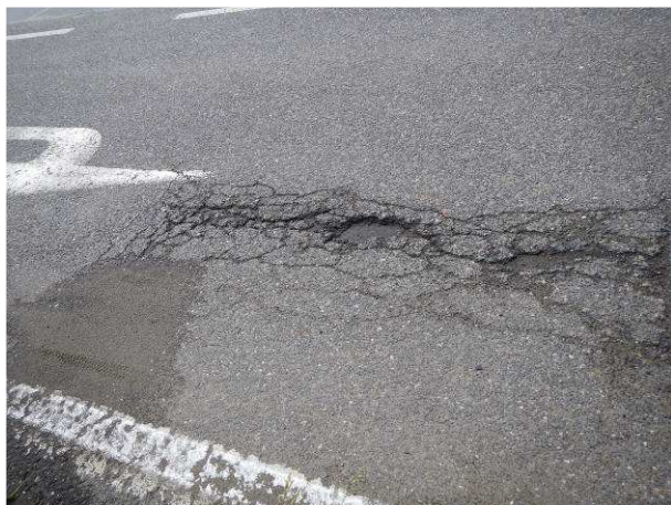
Hlubková koroze, výtluky, mozaikové trhliny
