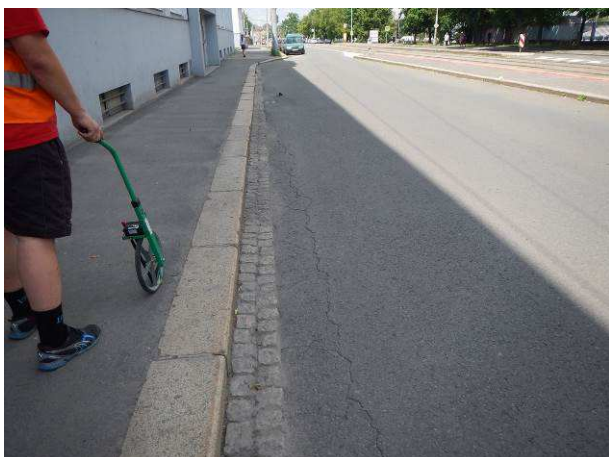
LJP – podélné rozvětvené trhliny
