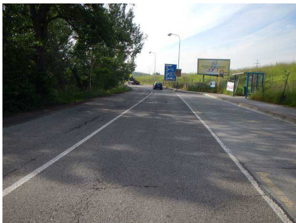
Hlubková koroze, podélné a příčné trhliny
