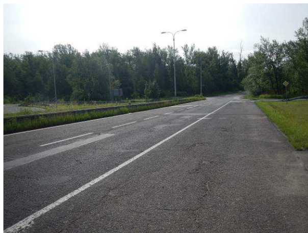
Hlubková koroze, trhliny, vysprávký
