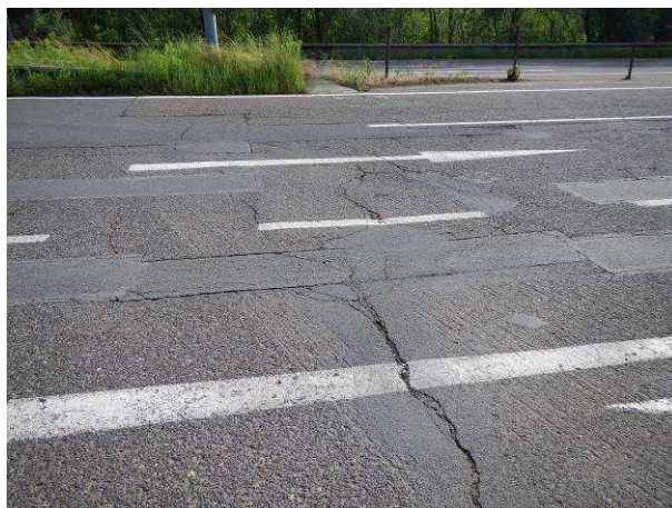
Hlubková koroze, mozaikové trhliny, vysprávký
