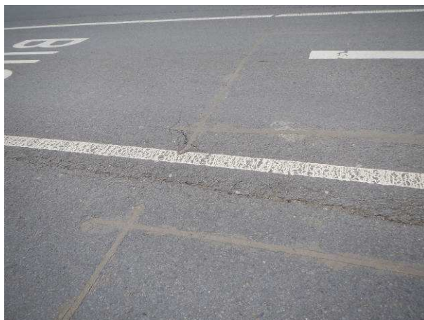
Hlubková koroze, podélná trhлина
