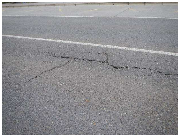
Hlubková koroze, mozaikové trhliny
