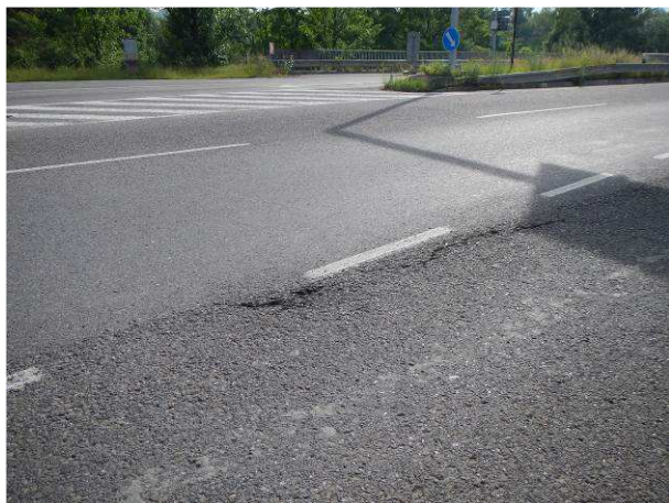
Hlubková koroze, podélná trhlina
