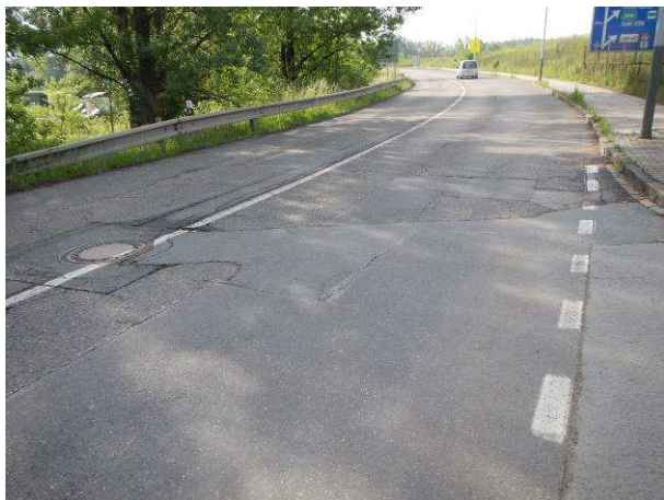
Hlubková koroze, mozaikové trhliny, vysprávkky,
