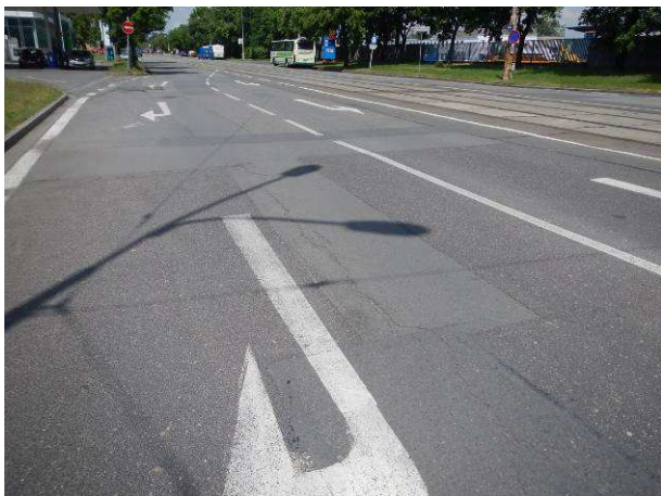
LJP - vysprávkky, trhliny, ztráta makrotextury
